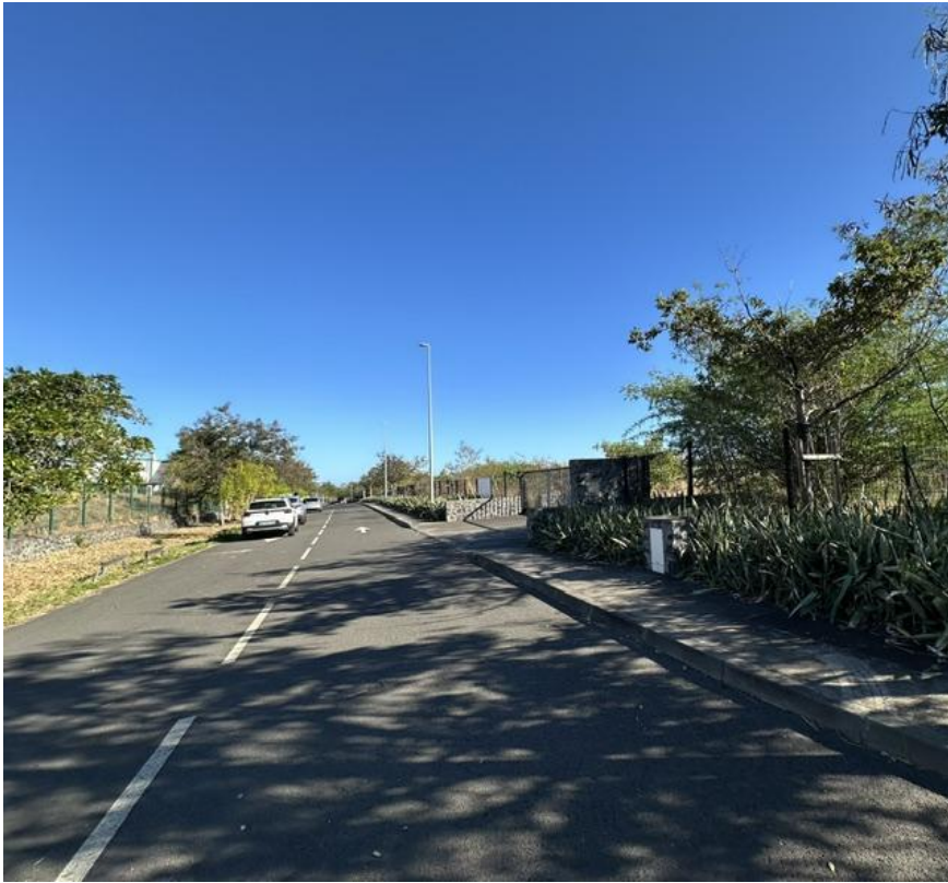
Figure 4: rue de Kyoto, ZAC Environnement secteur Ecoparc
