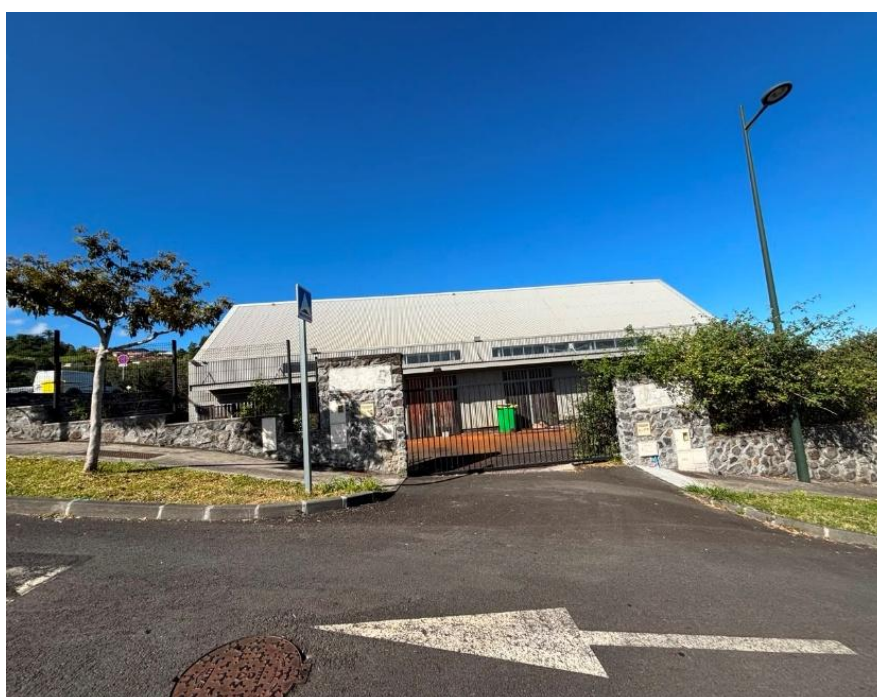
Figure 4 : Ateliers mitoyens 15a et 15b sur l'extension de la zone de Bras Montvert
