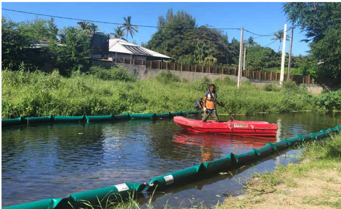
Expérimentation des barrages flottants sur la Ravine Hermitage – Avril 2024
