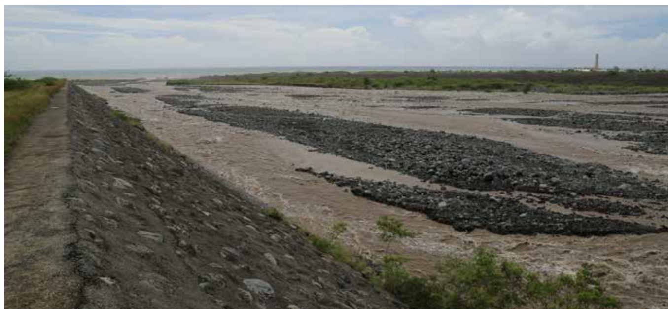
Sollicitation et déstructuration du confortement de l'épi 5 de la Rivière des Galets pendant le cyclone BELAL intervenu le 16 Janvier 2024.
