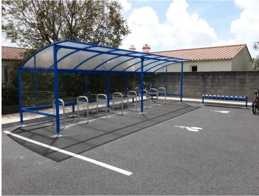
Figure 3 - Abri vélo et support trottinettes à l'école primaire de Commequiers (85) - www.abri-plus.com
