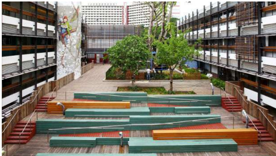
Figure 29 - Rampes à pente douce a été aménagé en cœur d'îlot - https://enablingvillage.sg
