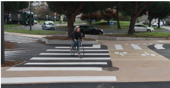
Figure 21 - Exemple d'illustration du giratoire à la hollandaise à Tours - Giratoire St Sauveur Inauguré en 2022, aménagement réalisé suite à un accident - Ingérop 2022
