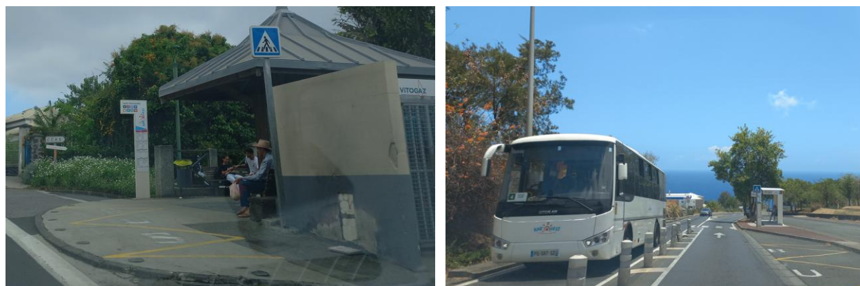
Figure 9 - Exemple d'arrêts non accessibles PMR Ingérop 2023
