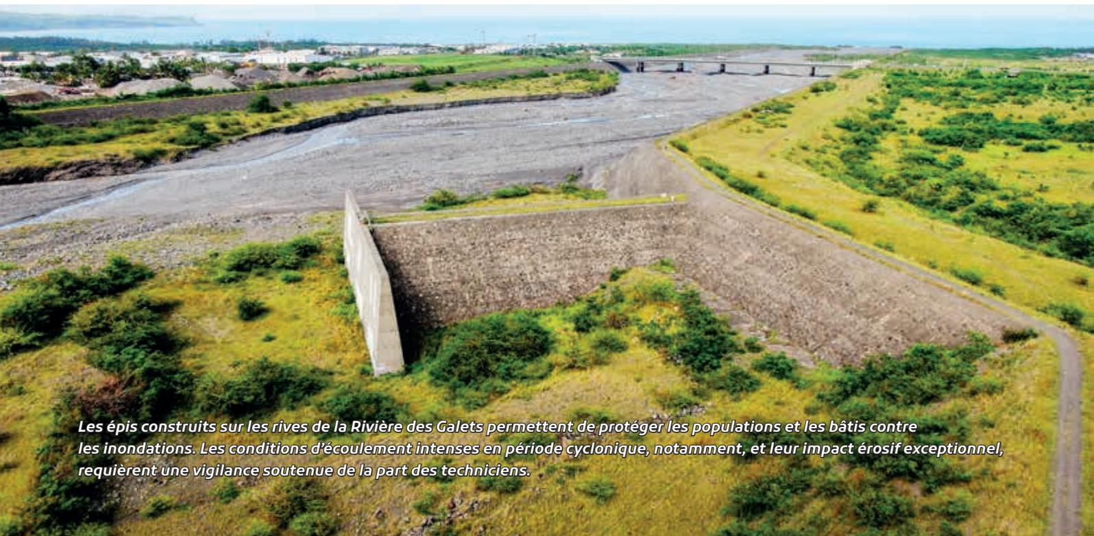
*Les épis construits sur les rives de la Rivière des Galets permettent de protéger les populations et les bâtis contre les inondations. Les conditions d'écoulement intenses en période cyclonique, notamment, et leur impact érosif exceptionnel, requièrent une vigilance soutenue de la part des techniciens.*
