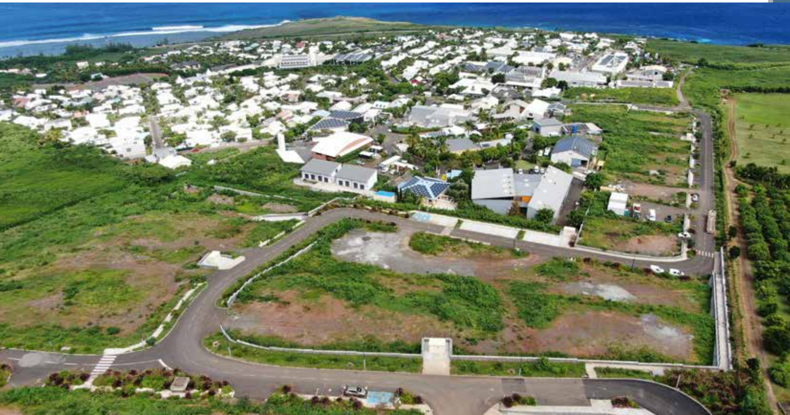
Construction de la zone d'activités économiques de la Pointe des Châteaux (Saint-Leu)
