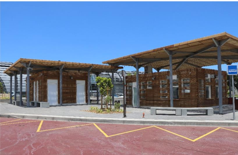
Les bâtiments abritent une agence commerciale mutualisée Kar'Ouest / Car Jaune et des toilettes publiques.
