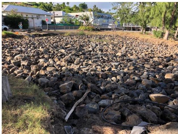
*Environ 2000 m<sup>3</sup> de sable viendront recouvrir ces blocs rocheux*
