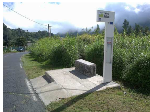
Photo 2 : Arrêt de bus partiellement accessible
