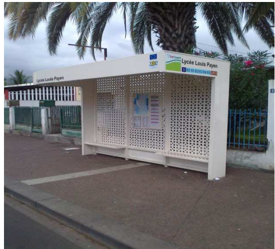
Photo 1. Arrêt de bus totalement accessible
