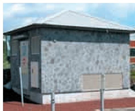
Poste de transformation électrique travaillé architecturalement, avec parement basalte et toiture de tôle teintée (Zone industrielle au Port)
