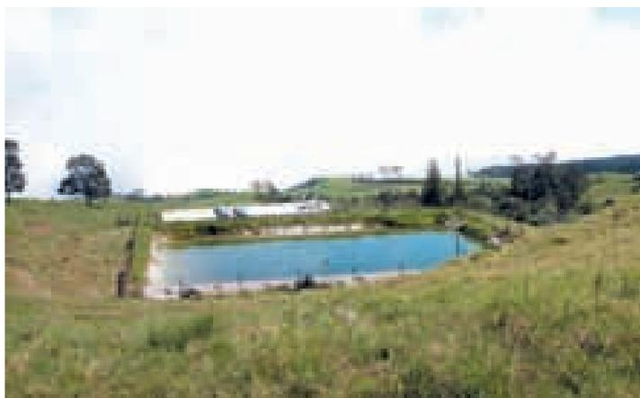
Bassin de rétention dans les Hauts de l'Ouest. L'enherbement des déblais et remblais facilite l'intégration du bassin dans les pâturages en place
