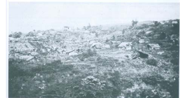
Camp des maîtres - Domaine de Grande Ravine - Trois-Bassins. Les Ruines de cette ancienne usine se trouvent aujourd'hui à Pissoneau sur la propriété de M. Antoine PÉJANGANDY (Coll. VIOT)
