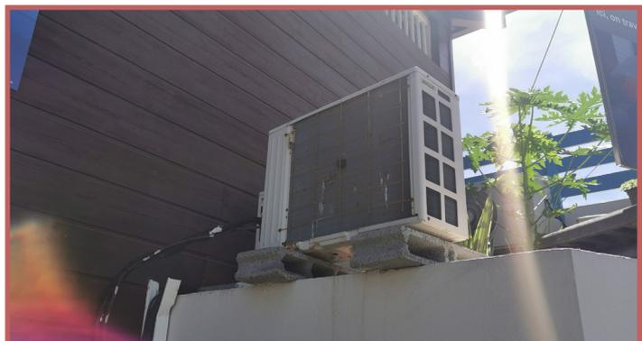
En plus d'être mal intégrée, l'installation du bloc extérieur est **dangereuse** : elle est complètement apparente et n'est pas fixée.
