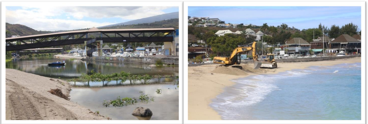
Cette année, plusieurs phases de travaux de recalibrage du cordon dunaire sur St Gilles les Bains ont eu lieu.
