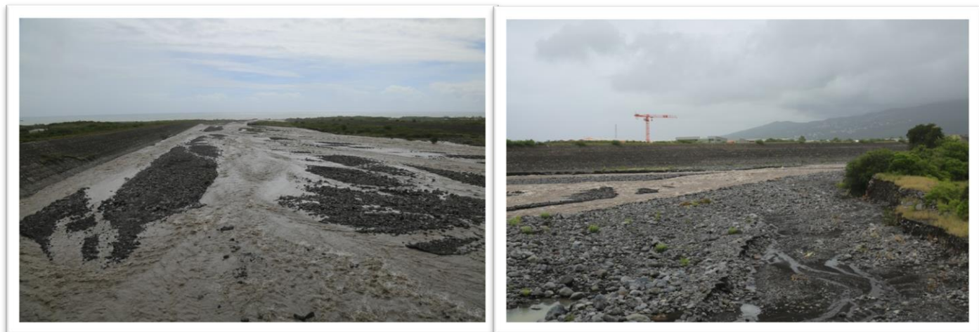
Les ouvrages de la rivière des galets sont aussi concernés par la Gemapi
