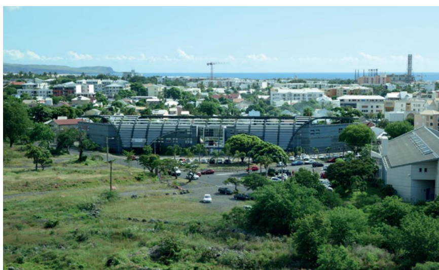
Figure 5 : Vue depuis le siège du TCO
