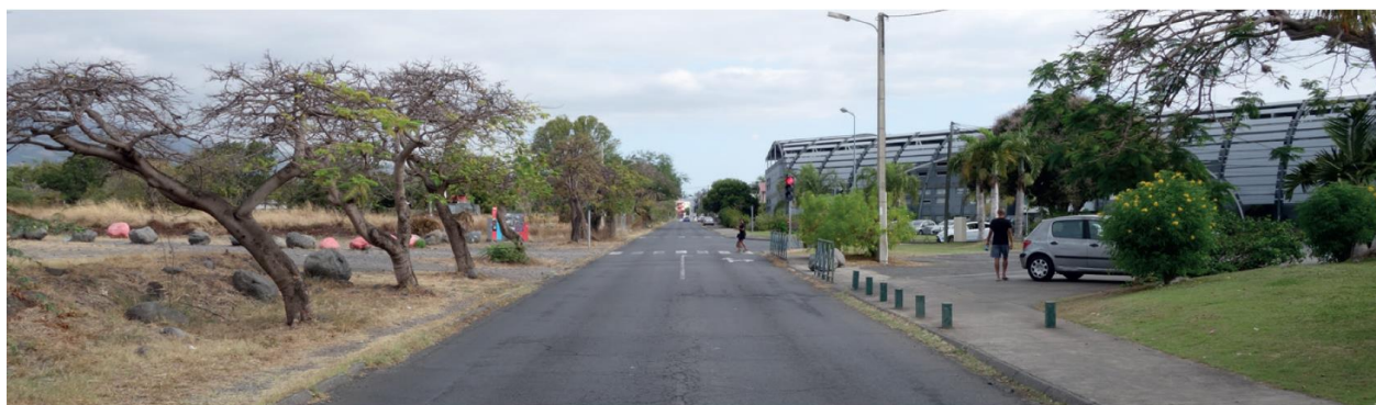
Figure 4 : Vue depuis la rue du 20 décembre
