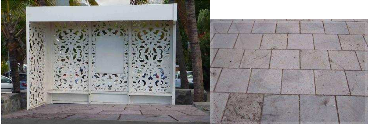
Figure 19. Exemple de station bus, église de la Possession - dallage basalte en pavés - Source photo Helios
