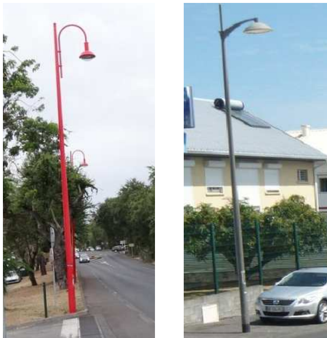
Figure 29. Eclairage public sur la rue Leconte de Lisle (photo de gauche) et sur la rue Sarda Garriga (photo de droite)
