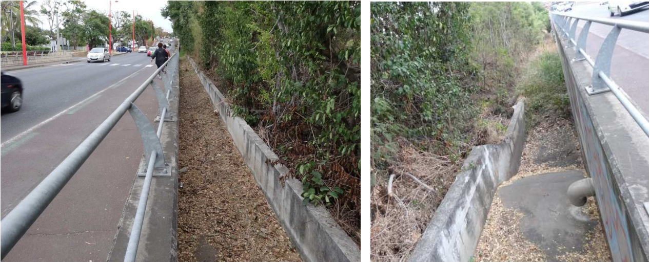
Figure 28. Ouvrage existant en aval du réseau projeté
