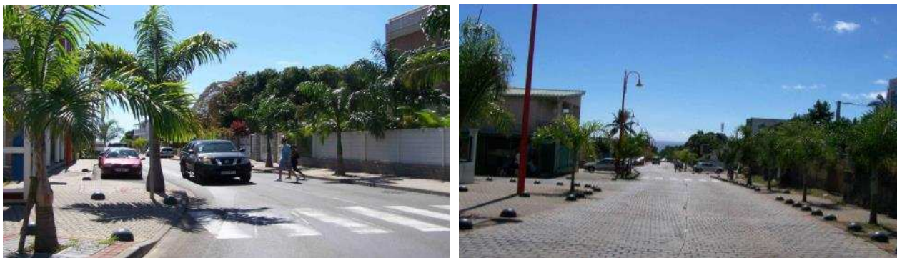
Figure 11. Pavés béton centre ville de la Possession sur trottoir et chaussée – Source HELIOS
