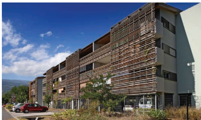
Le cabestan, parc de la poudrière, Saint-Paul (TT architectures)
