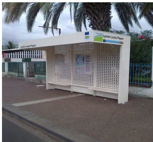
Photo 1. Arrêt de bus totalement accessible
