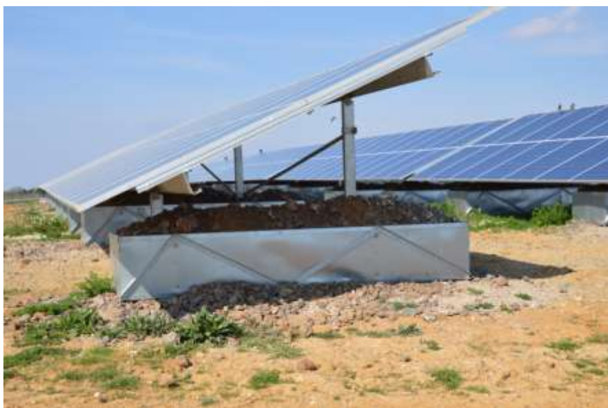
Figure 8 : type de lestage des panneaux solaires
