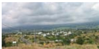
Eperon : premier front bâti depuis le littoral - Passage de la Route des Tamarins
