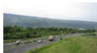
Zone Boisée à l'Amont de la 4 voie de Cambaie
