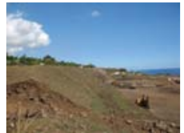
Talus entre la ZAC et le quartier du Portail
