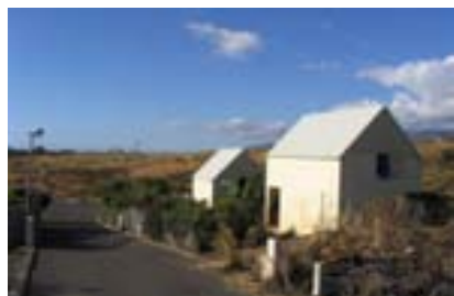
Eperon : RHI en bordure de Savane - vue sur future déviation de la RD 10
