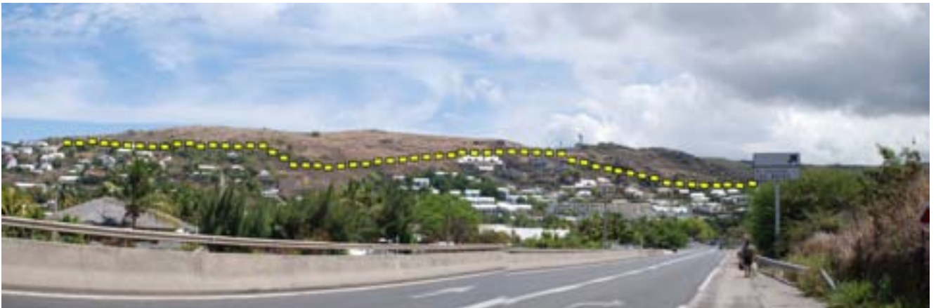
Une urbanisation excessive des flancs.
