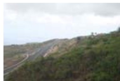
La route des Tamarins passe sur la corniche à l'aval de Trois-Bassins
