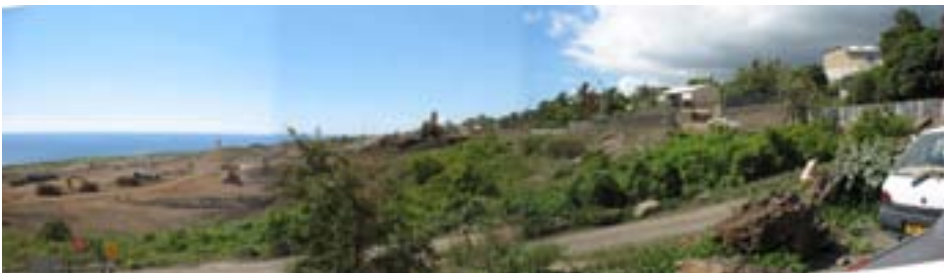
ZAC du Portail en travaux
