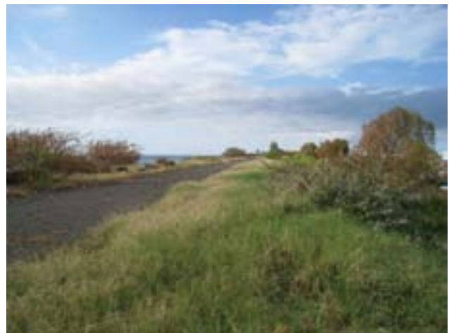
Digue protégeant le port
