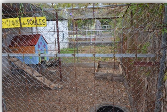
Grillage à poule doublé d'une maille de fer à béton et structure en bar alu coulés dans une base de béton
